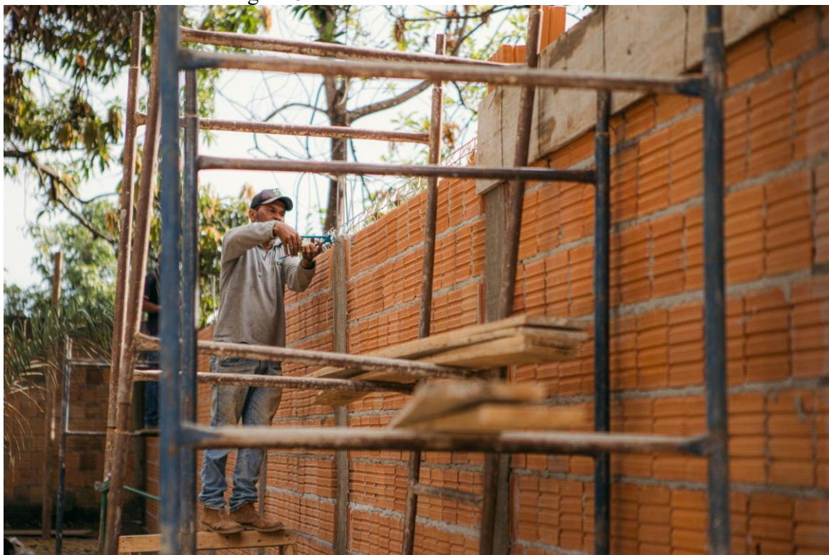
Imagem 6: Reforma na estrutura das casas.
